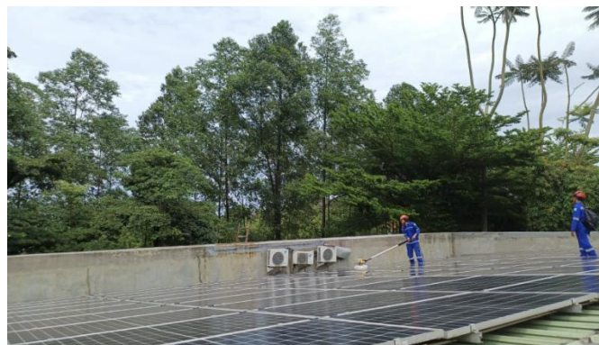
Gambar 17. Pertumbuhan pohon penyebab shading menutupi kelompok modul surya
