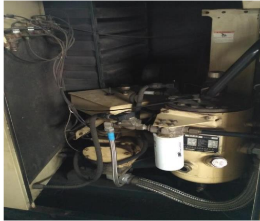
Gambar 2. Kompresor Screw ML45 di Unit Boiler
