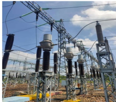
Gambar 3 Arrester Gardu Induk Keramasan
