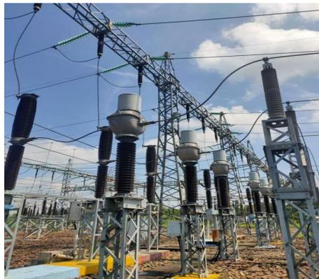
***Gambar 3 Arrester Gardu Induk Keramasan***
