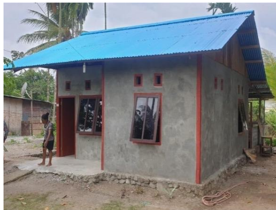
Gambar 3. Proses Pembangunan Rumah Layak Huni Masyarakat Asli Suku Wate di Kampung Nifasi.
