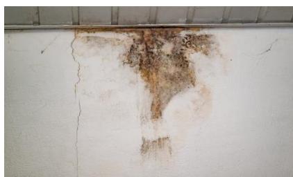
Gambar 11. Dinding Yang Berjamur.
