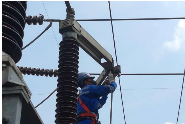
Gambar 3. Perbaikan Hot Spot pada Disconnecting Switch
