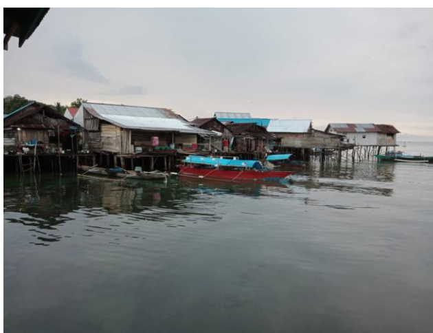
Gambar 5. Kondisi permukiman Kampung Nelayan Desa Labuan.
