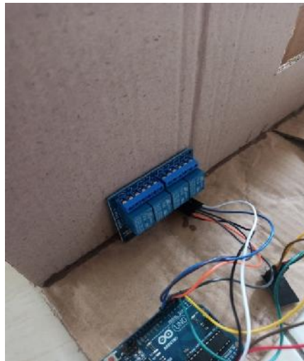
Gambar 5. Pemasangan Modul 4 Relay
